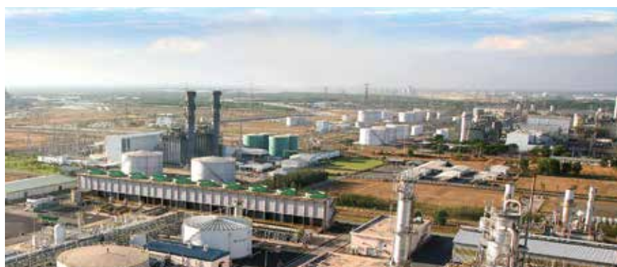
Nhà máy Đạm Phú. Ảnh: PVFCCo
