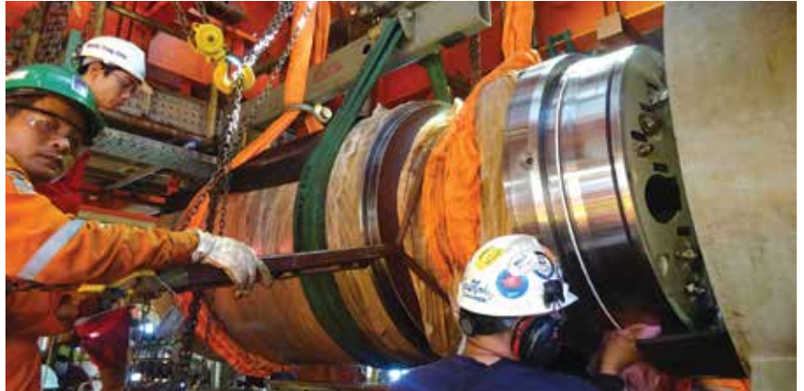
Tiến hành lắp đặt lõi mới cho máy nén khí. Ảnh: HLHV JOCS
